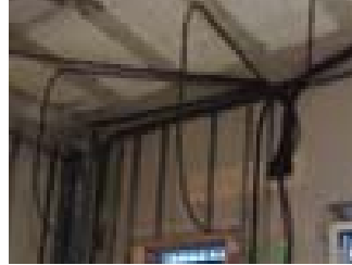
COLOCACION Y FIJACION INSTALACIONES
