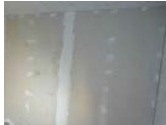
ATORNILLADO PLACA Y ENCINTADO JUNTAS Y TACOS
