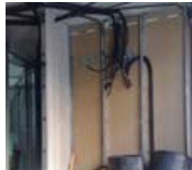
COLOCACION DE PLACAS POR UN LATERAL Y FIJACION INSTALACIONES
