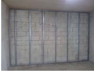
COLOCACIÓN PERFILERÍA
